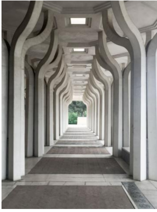
شكل (34) ويظهر به أحد أروقة المركز الإسلامي ويظهر فيه تصميم العمودالمكون من أربعة أجزاء متشابهة
