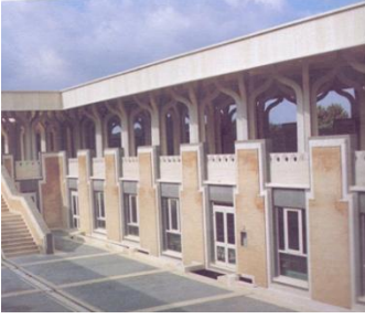
شكل (63،64) لقطات توضح الأعمدة الحاملة للأسقف المحيطة بالممرات المحيطة ببناء مدخل قاعة الصلاة الرئيسية.
