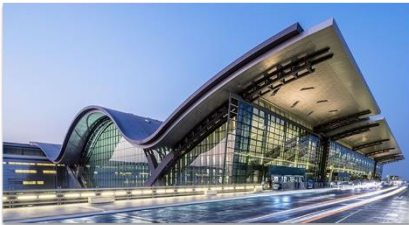
شكل 1 يوضح الهيكل المعماري لمطار حمد الدولي بالدوحة-قطر؛ ويظهر به الشكل المنحني التعبيري للهيكل الخارجي غير التقليدي للمطار المبنى المستوحى من أمواج المحيط والكثبان الرملية؛ وهو ما أعطى إحساساً بالديناميكية والحركة. - https://www.archdaily.com/917458/hamad-international-airport-pas
