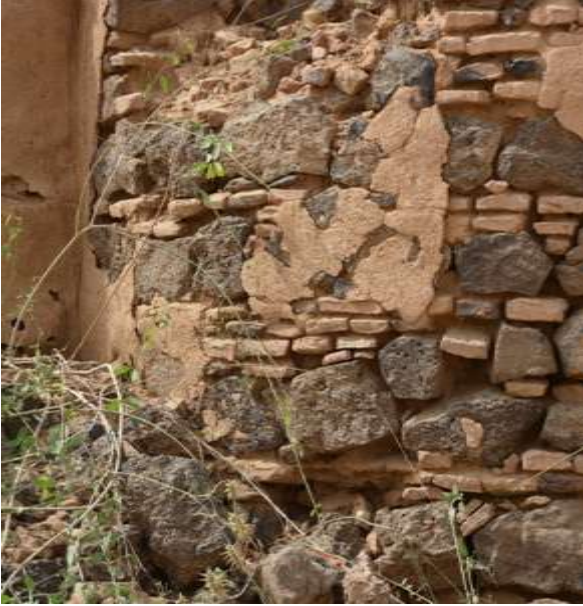
شكل رقم (7) توضح تلف وانفصال طبقات الملاط بفعل تأثير الرطوبة الجوية وظاهرة التكاثف .
