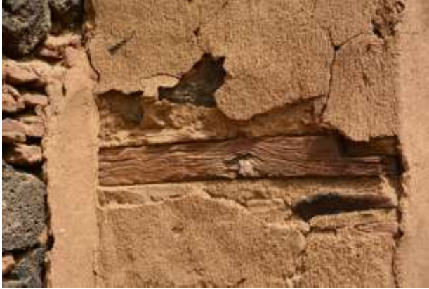
شكل رقم (8) توضح تلف وضعف الألياف الخشبية لأحد الدعامات الموجودة داخل الجدران.
