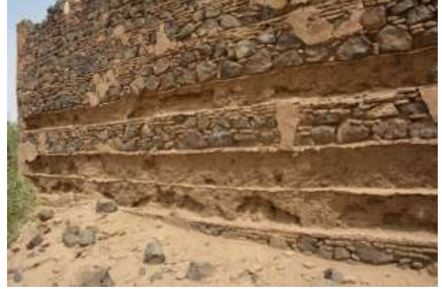
شكل رقم (9) توضح عمليات النحر لطبقات الملاط
