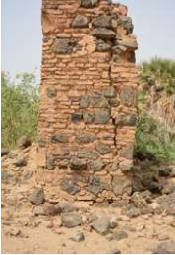
شكل رقم (18) توضح أحد الحوائط المتبقية وما تعاني به من شروخ
