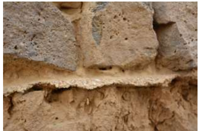
صورة رقم (6) توضح تلف المونة وتبلور الأملاح في أحد الجدران بفعل الرطوبة الأرضية .
