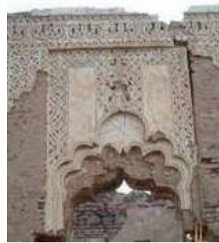
شكل رقم (15) توضح الزخارف الجصية التي تزين واجهة البيوت وما آلت له من تدهور
