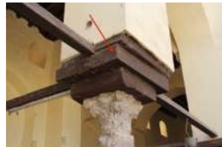
شكل رقم (11) السهم يشير إلى الطبلية الخشبية الحديثة أعلى العمود
