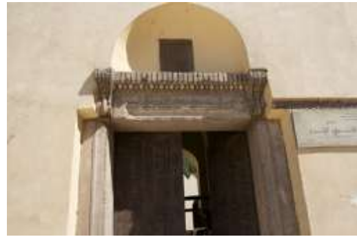
شكل رقم (2) توضح مدخل المسجد
