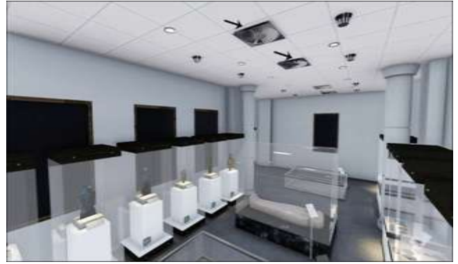
صورة رقم (٢٥) توضح تركيب سقف معلق و وحدات تكييف للتحكم في الظروف المحيطة بالأثر من (حرارة - رطوبة).
