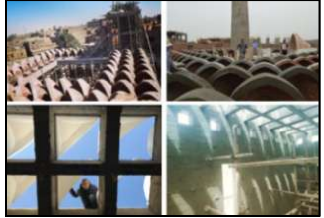
الأشكال من (٨ ، ٩) يظهر بها تصميم سقف المسجد من المثلثات الكروية كيفية توجيهها للتحكم في شدة الإضاءة داخل المسجد .
