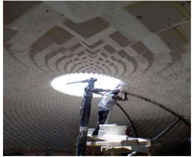
شكل(١٦) يوضح البلوك المستخدم في بناء القبة من الداخل .
