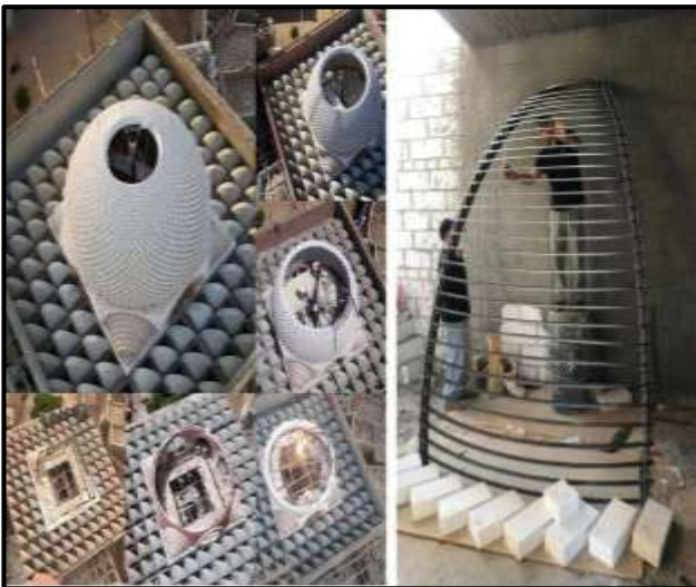
شكل (١٤-١٥) يوضح استخدام البرجل المزدوج وذلك لعمل مماسين داخلي وخارجي لتركيب البلوك الأبيض
