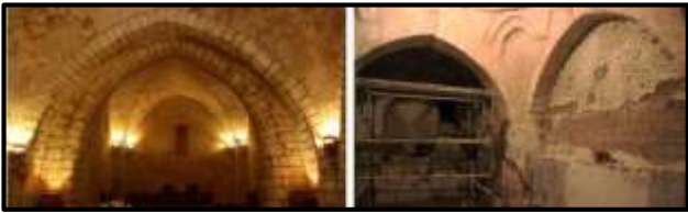
شكل رقم (٧-٨) القاعة الرئيسية لحمام السمرة قبل عملية التأهيل ،لقاعة الرئيسية لحمام السمرة بعد عملية التأهيل .
