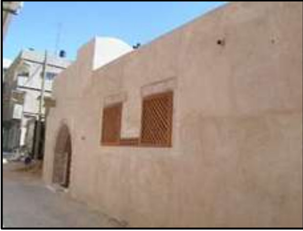
شكل رقم (٣) يوضح الواجهة الرئيسية للمبنى وهي واجهة بسيطة تتناسب مع الخصوصية المطلوبة للمبنى كحمام .
