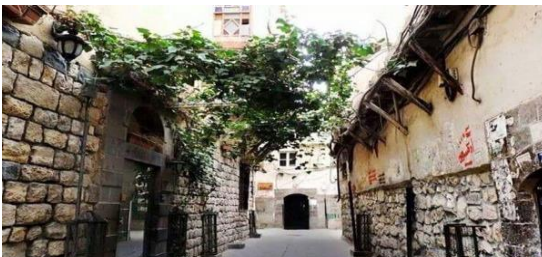
(7) صورة توضح احد الحارات التي تحتاج الى ترميم
