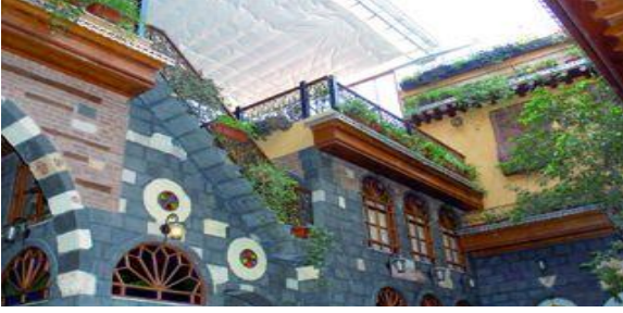
(8) صورة توضح عملية الترميم لاحد المباني التاريخية
