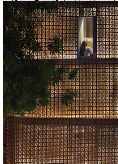
(شكل رقم 11 ورقم 11-أ) مبنى سكني في مدينة فينتام حيث تسمح الواجهة المستوحاة من المشربيات بمرور الهواء للدخل مع الإبقاء على الظل و الحماية من الشمس لمن هم في داخل المبنى .
